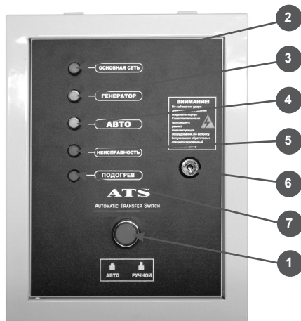
Рис. 14 Контрольная панель блока ATS
